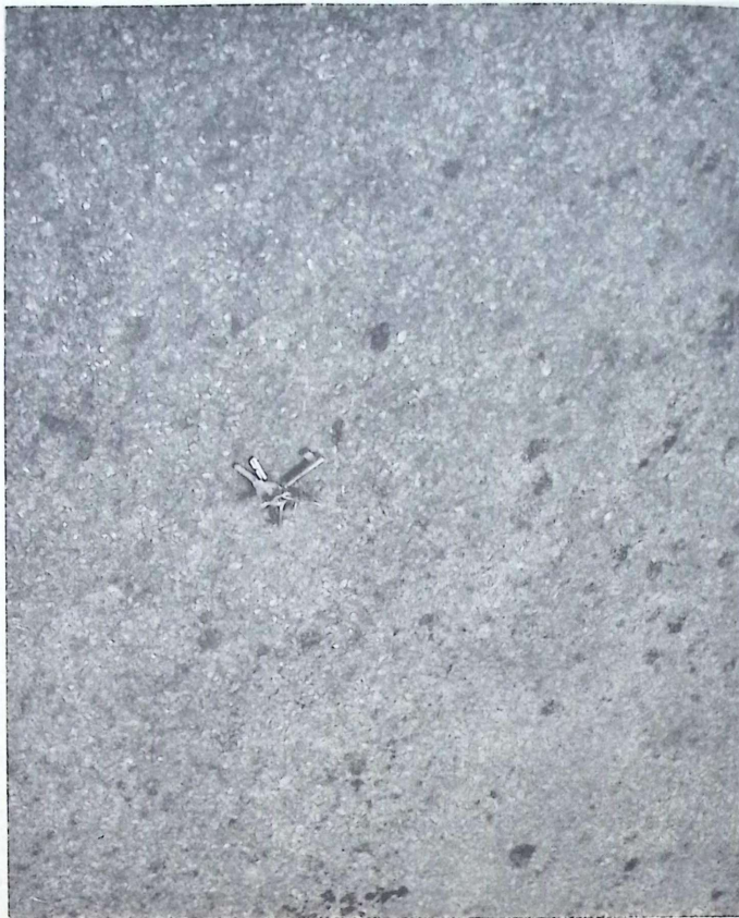
Slika br. 7 — Ugrađeni bitumen Sokolovogorska 45/120 — fini habajući sloj
