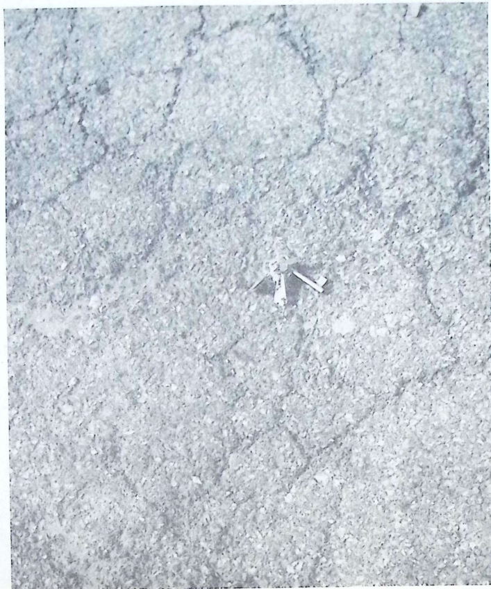
Šlika br. 5 — Ugrađeni bitumen Belajim 55/50 — fini habajući sloj
