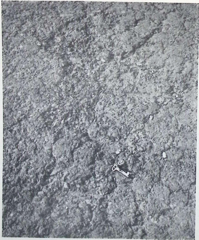
Slika br. 6 — Ugrađeni bitumen Belajim 55/50 — grubi habajući sloj
