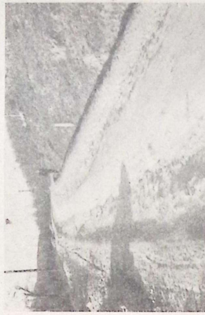
Slika 1 Podpuns, istrošeni tucanički kolovoz na cesti I. reda u planinskom području, uslijed nedovoljnog održavanja kolovoza (1,5 x)
