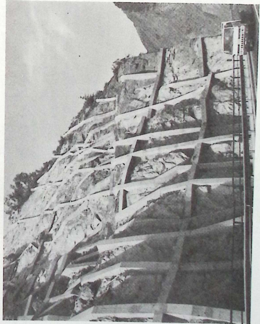
Slika 5. Saracija pokosa stijene betonskim roštijem sa girama na cesti Šhiffa — Berroushita, DNR Alžir
